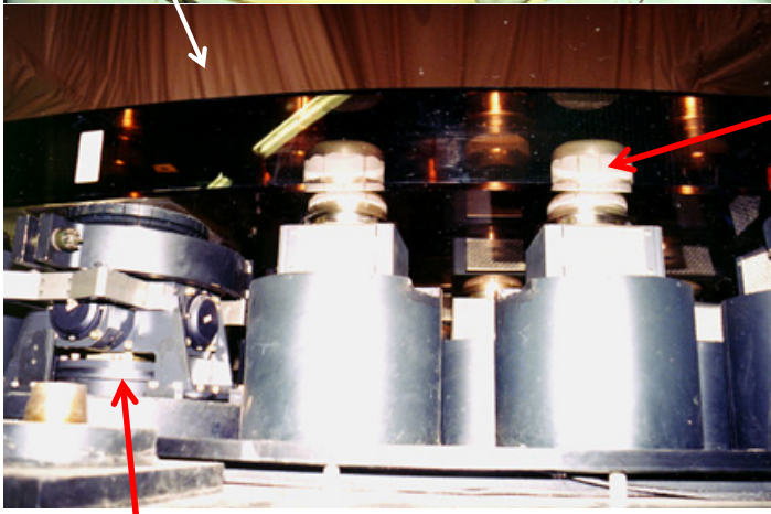
固定点(支持点)(3カ所)
