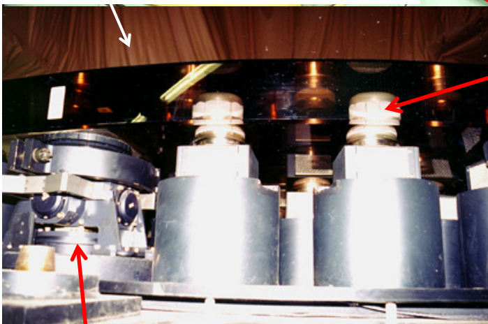
固定点(支持点)(3カ所)
